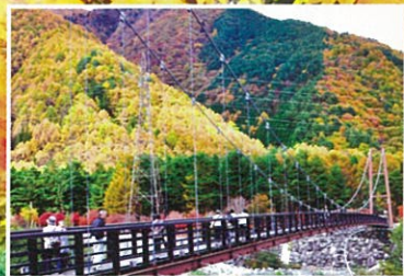
駒ヶ根ファームスこまくさ橋
